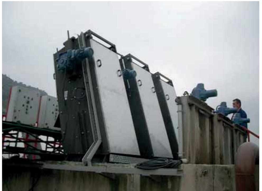
La reja de limpieza automática es un equipo monobloc diseñado para ser instalado en canales y extraer de forma automática los sólidos del agua mediante un desbaste. Este modelo G (gama pesada) es útil para canales de hasta 3m de anchura, una altura del agua de 11m y con una carga de elevación de 800Kg.
